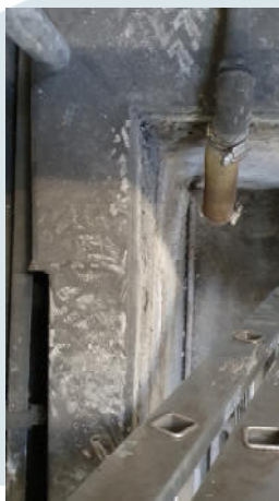
Bestandsaufnahme Stahlwanne m. Rissen, Aufmaß für den Inliner, Freigabezeichnung, Vorfertigung.
