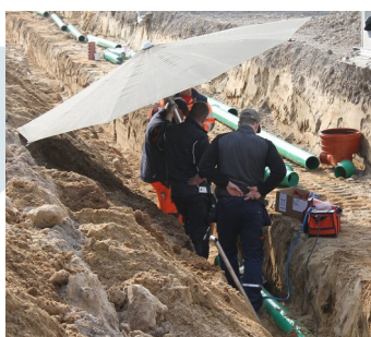
Anschluß Schweißgerät
