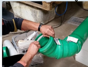
Einsetzen d. Schweißringes
