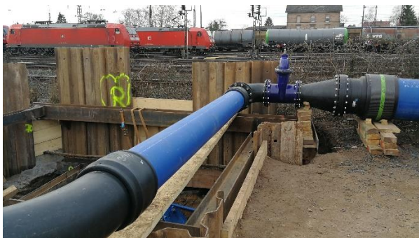
Reduktion d630 auf Sonderflansch DN500
