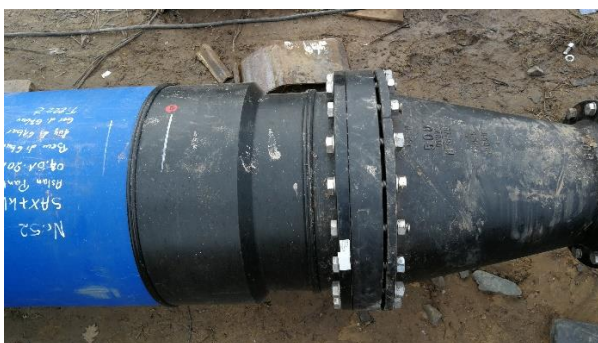
Reduktion d630 auf Sonderflansch DN500
