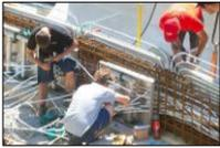
Mit einer komplett neu entwickelten Kältetechnologie der Universität Innsbruck, wird die erste Rennrodelbahn dieser Bauart aktuell mit dem AQUATEC Verbundrohrsystem von Jäger A-Hohenems ausgestattet.
